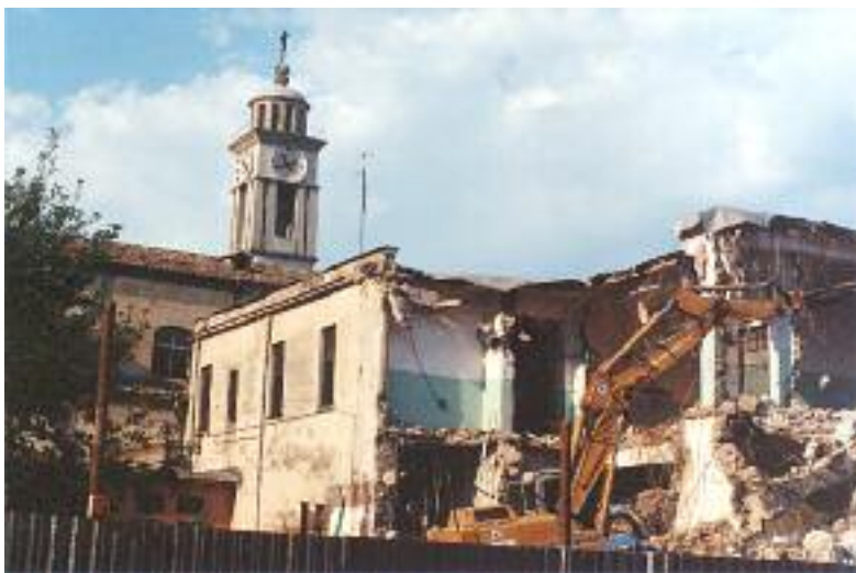
Novembre 2000: la demolizione dell'ex convento francescano in piazza Diamare.
