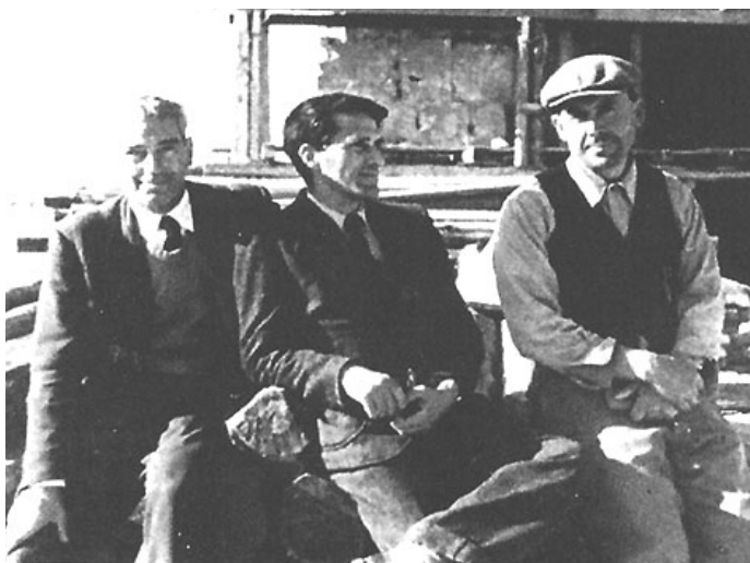
L'arch. Giuseppe Poggi a Montecassino nel corso dei lavori di ricostruzione, con due suoi assistenti.
