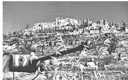
Foto 5 - Piedimonte San Germano alla fine delle ostilità.
