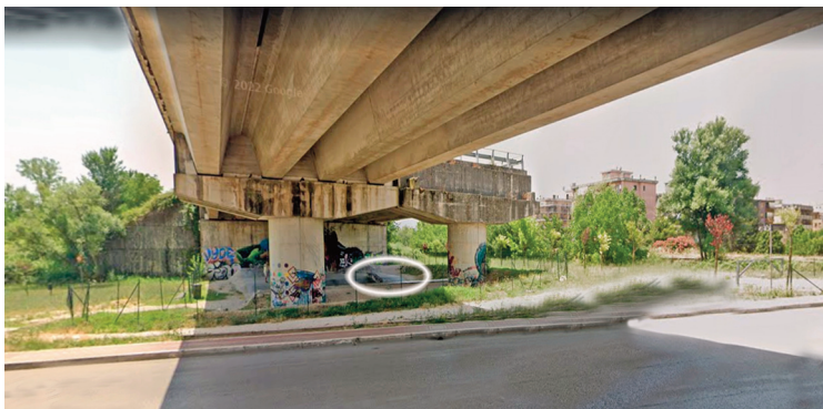
Zona dello scavo al Quinto Ponte.
